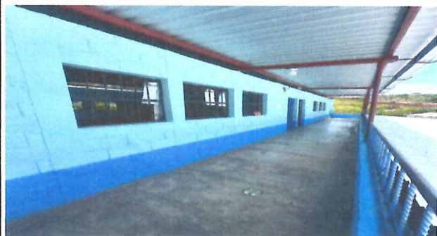
FOTO1: PISO Sustitución de piso de concreto con acabado liso por piso cerámico, incluyendo preparación de superficie y nivelación.
