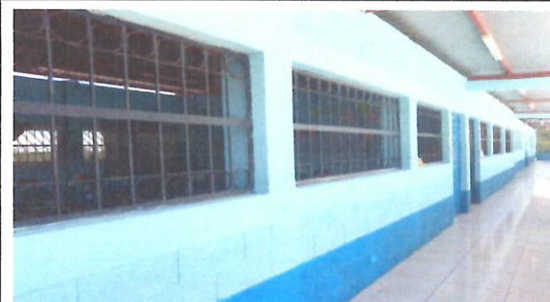
FOTO3: VENTANAS Sustitución de ventanas, sistema de apertura. Corredizas, Perfiles color blanco estandar, Material del marco: PVC Material de la ventana: Vidrio, sellado perimetral
