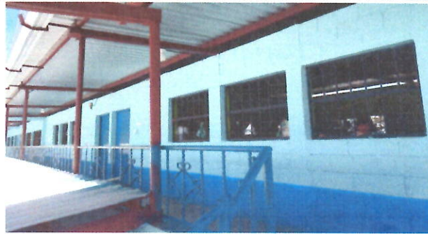
FOTO2: VENTANAS Sustitución de ventanas, sistema de apertura. Corredizas, Perfiles color blanco estandar, Material del marco: PVC Material de la ventana: Vidrio, sellado perimetral
